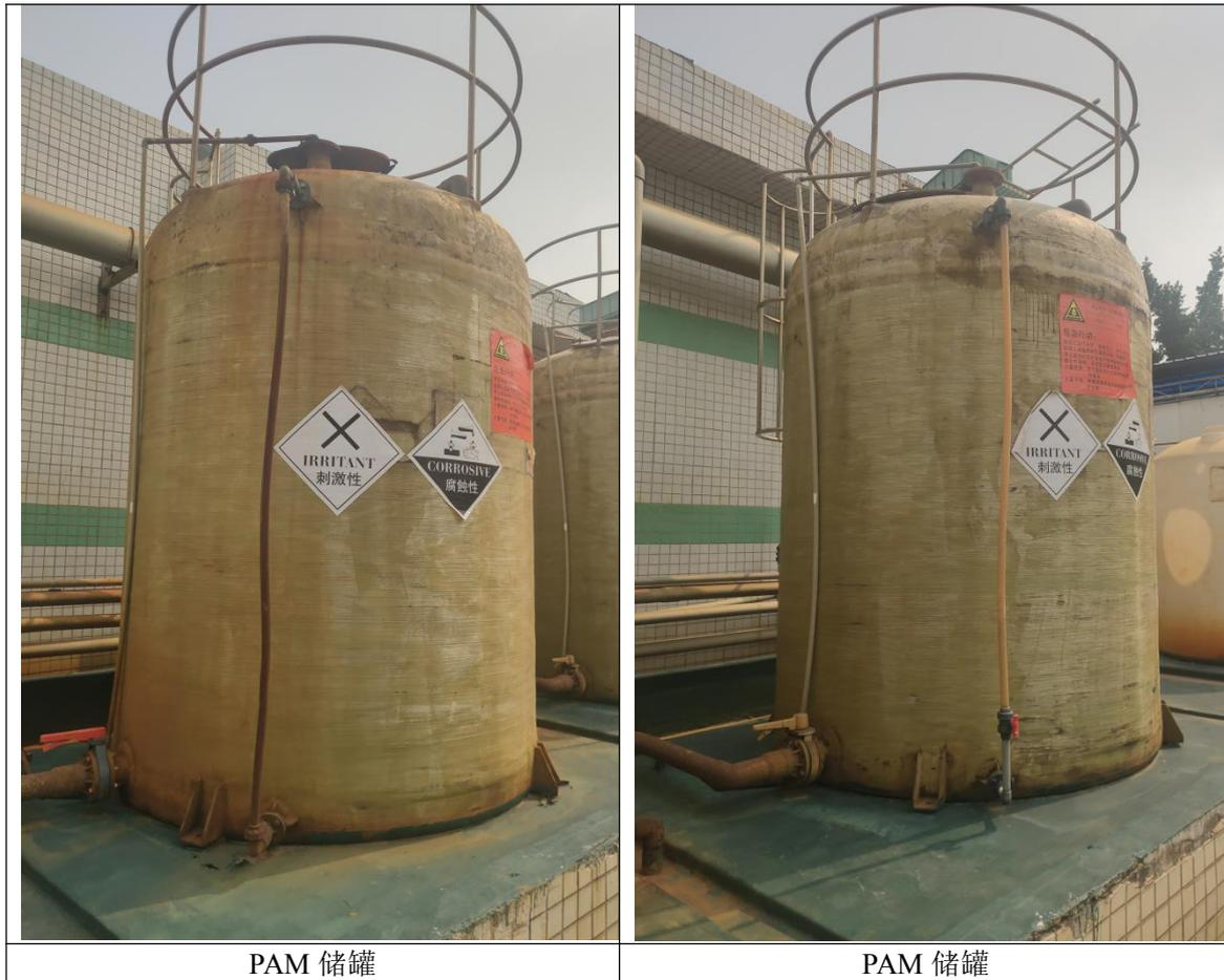
图 4.2-4 二厂区直接接地的地上储罐现场照片
